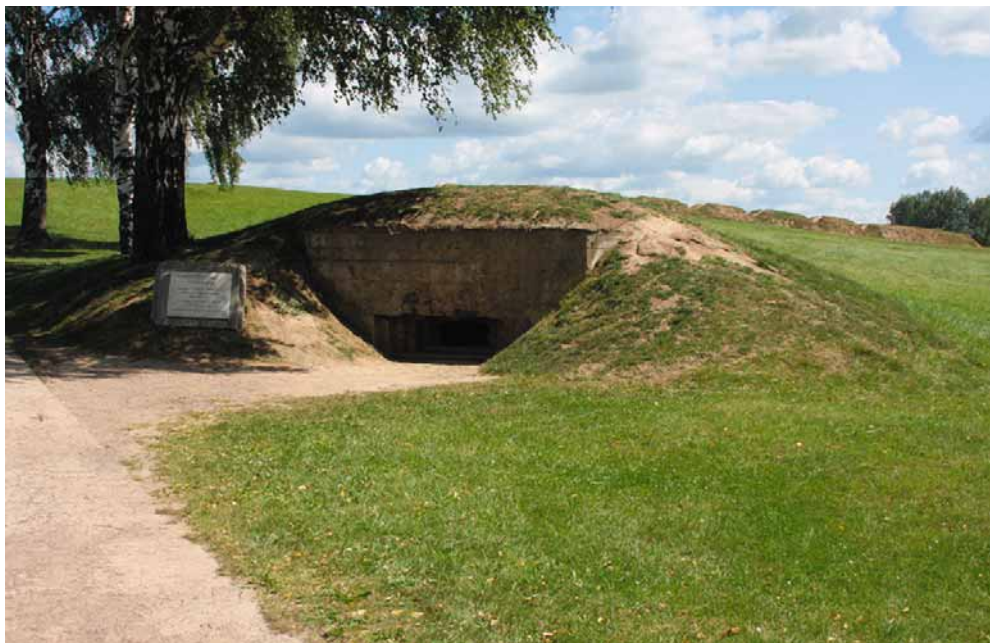
Долговременная огневая точка у Батареи Раевского
